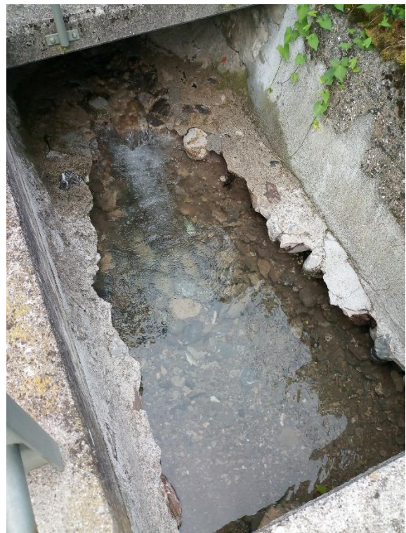
Foto 2: erosione del fondo del rio Aip
